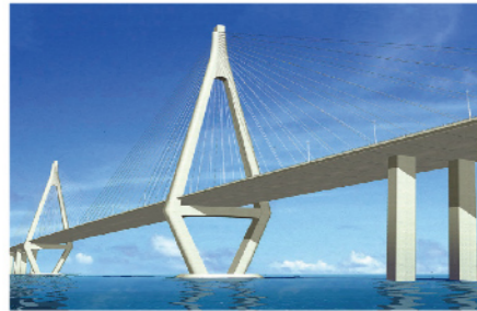
世界上最长的隧桥结合工程上海长江隧桥工程
